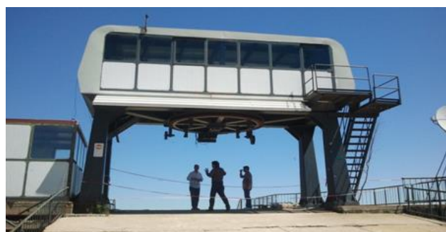
Figura MC-1: Vista esterna della stazione d'arrivo della vecchia seggiovia di Monte Curcio, ove sarà implementato l'Osservatorio Climatico -Ambientale
